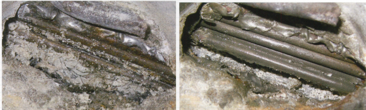
(c) B 橋 A1 側の上縁定着④の上側削孔位置
