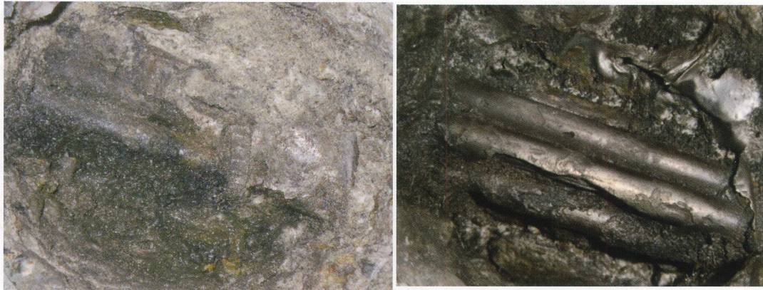
(a) M 橋 A1 側の上縁定着③の上側削孔位置
