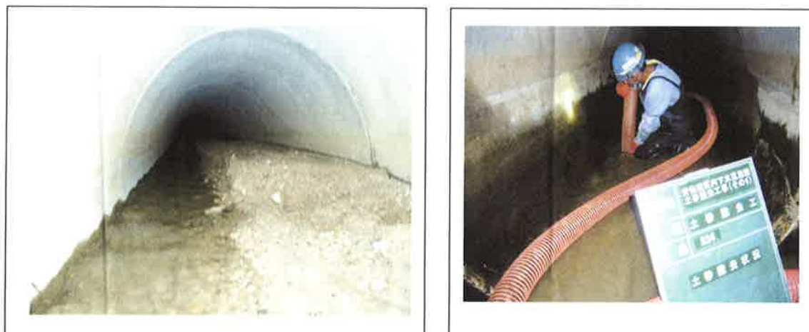
図 3-4 下水道管路への土砂流入と除去作業
