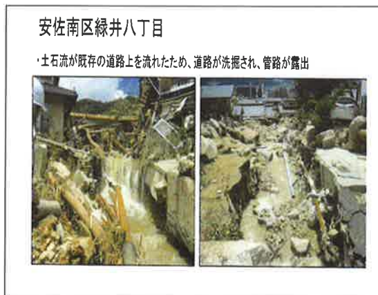
図 2-5 安佐南区緑井での土石流と管路被害 5)
