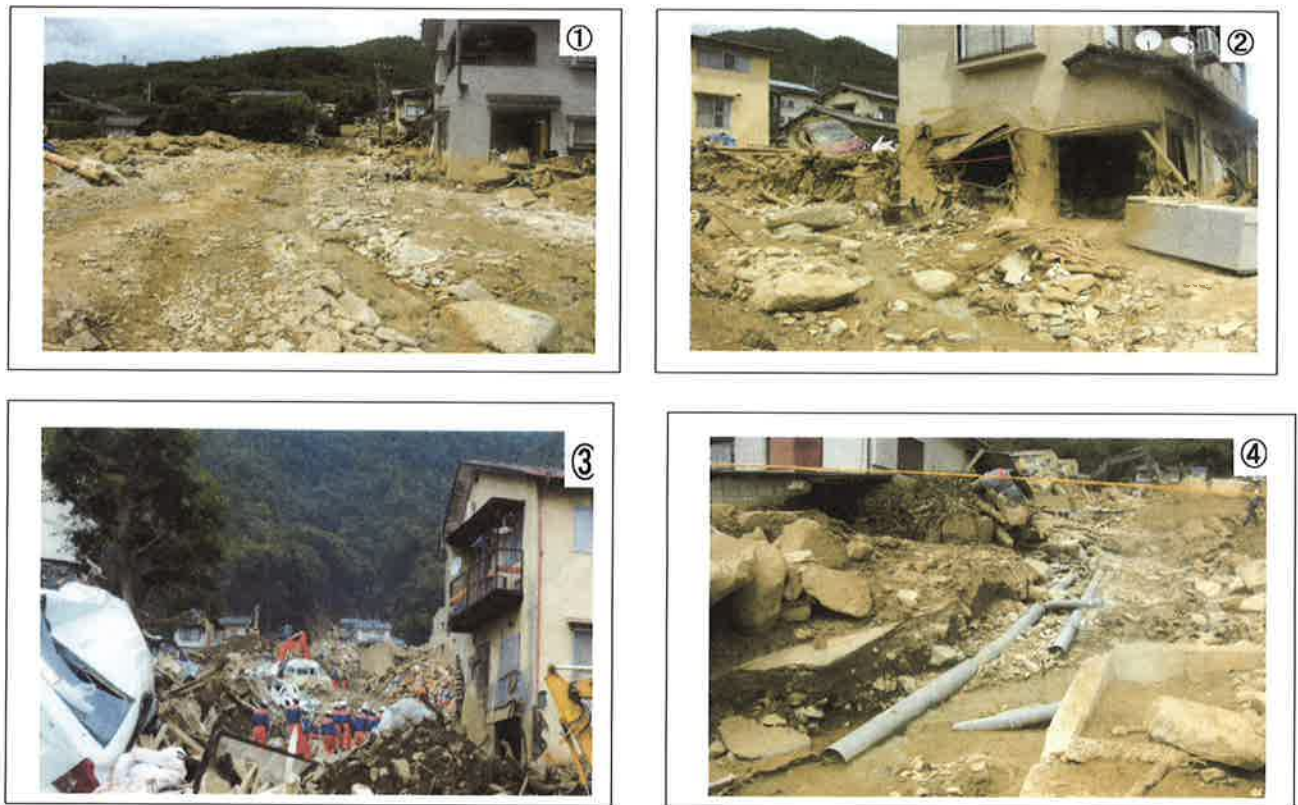
図 3-3 下水道管路被災路線に沿う土砂災害の状況（緑井）
