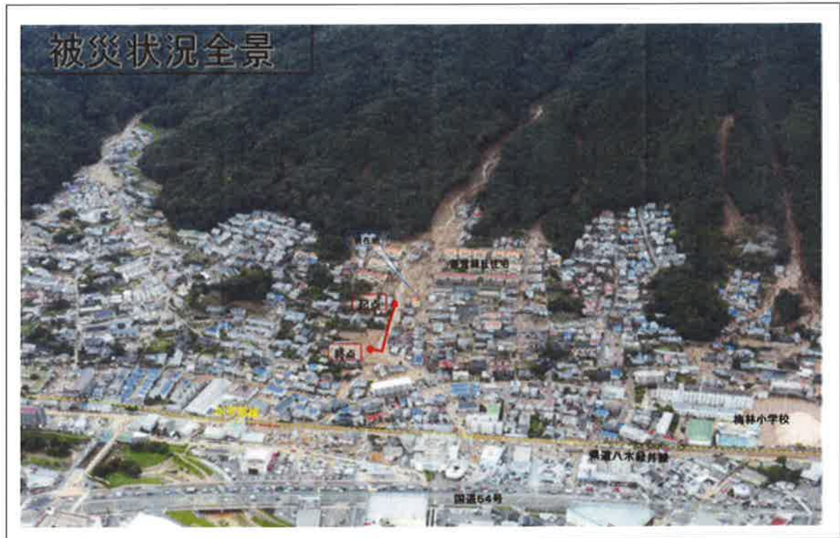
図 3-1 下水道管路の被災路線（矢印部分）
