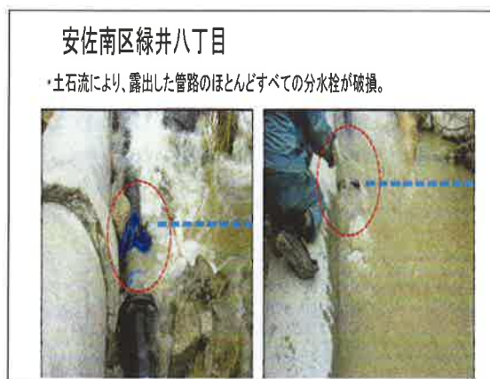
図 2-5 安佐南区緑井での土石流と管路被害 5)
