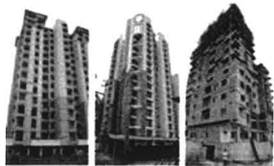
図-6.4 カトマンズ市内高層ビル破損
