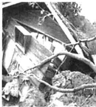
図-7.3 土石流による家屋損壊
