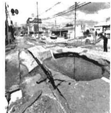
図-7.4 液状化による地盤陥没
