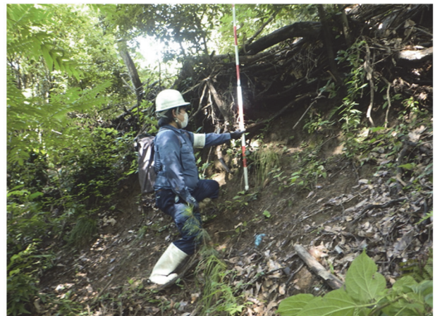
写真2 斜面中腹の状況。 高さ1.5m程度の古い崖が複数分布することが確認される。斜面内の表層は過去に表層崩壊を生じており、不安定な状況であると考えられる。
