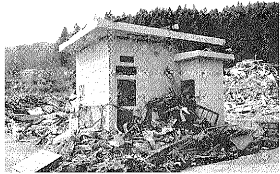
図-5. 津波で被災したポンプ場(岩手県大槌町)
