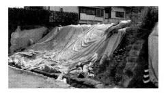
写真-1.2 ひな壇部分の変形・崩壊被害
