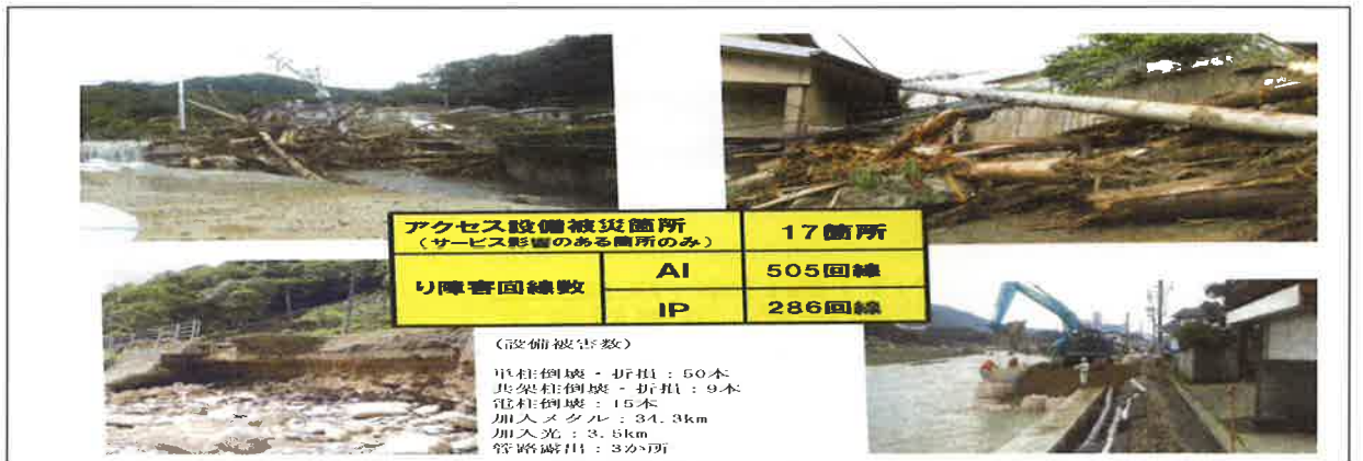
図-19 通信ケーブル・電柱の被害
