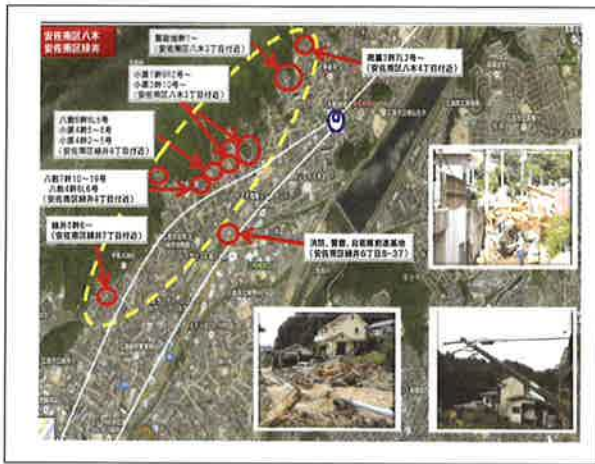
図-16 八木・緑井・可部地区での架空ケーブル切断位置
